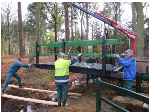
Vrijwilligers plaatsen een nieuwe brug in de wandelroute.
